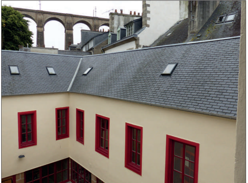
Depuis 2014, d'importants travaux de rénovation ont été réalisés, afin de maintenir en service un ensemble de bâtiments construits au XIX e siècle.
