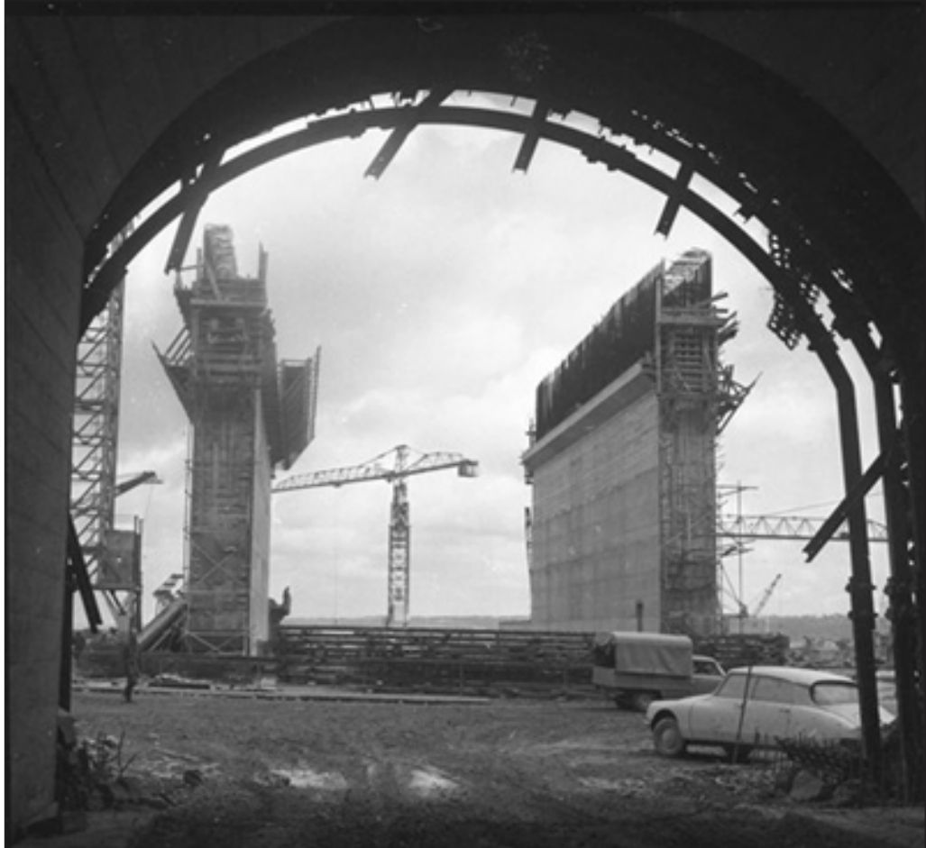
La base de sous-marins de l'île Longue en construction, en avril 1969. (photo DR)
