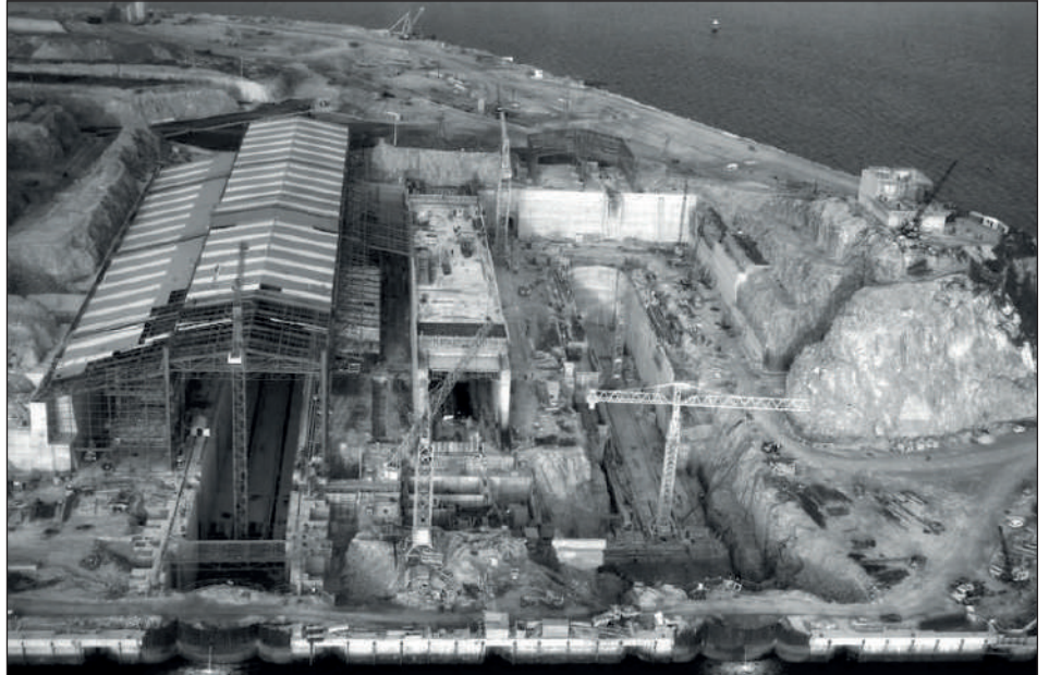
Le chantier titanesque de construction des bassins de l'île Longue entre 1967 et 1969. (Photo DR)
